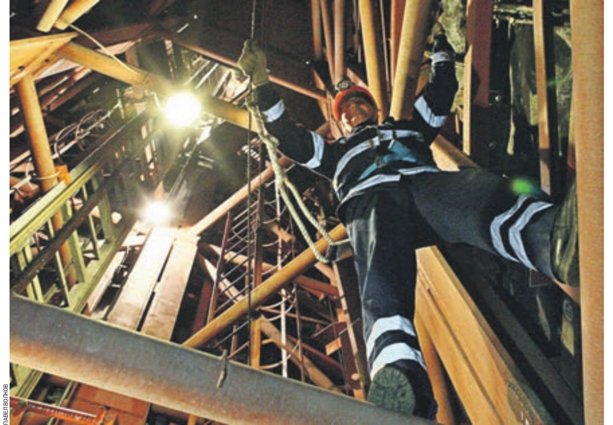
Вчера 17:20 Инженер Гормоста Андрей Мальхин проверяет внутреннюю конструкцию монумента Победы на Поклонной горе
